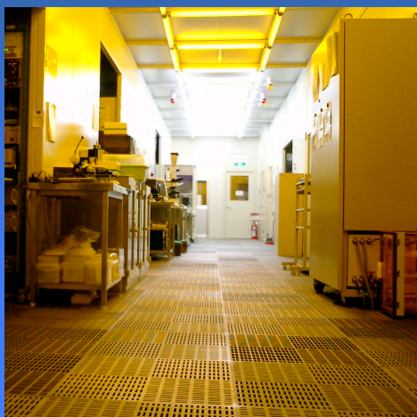
広島大学ナノデバイス・システム研究センター スーパークリーンルーム（0.1 \mu m, クラス10）
